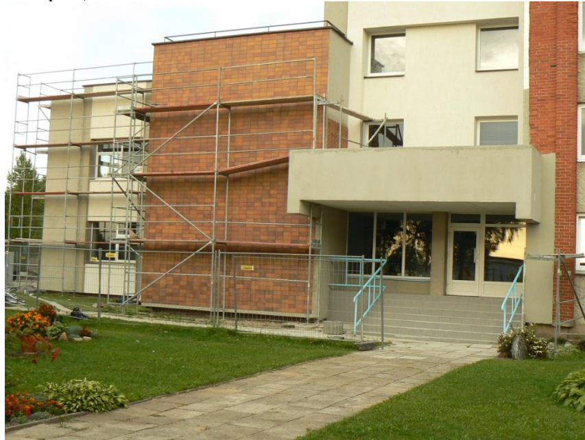
32 pav. Kolegijos pastato, esančio Aukštaičių g. 9, apšiltinimo darbai
