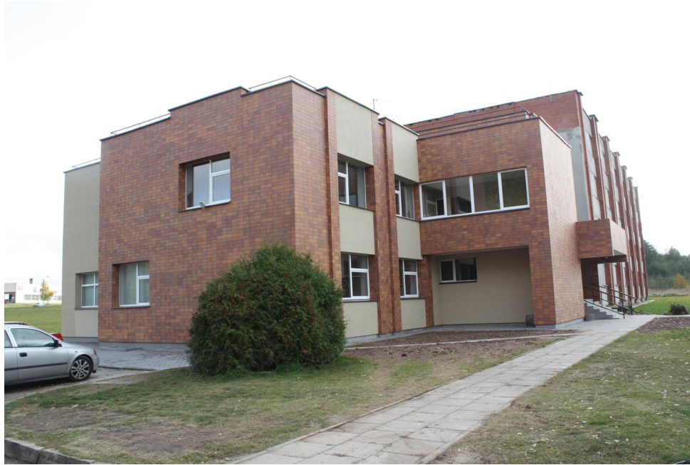
34 pav. Baigti Kolegijos pastato, esančio Aukštaičių g. 9, apšiltinimo darbai
